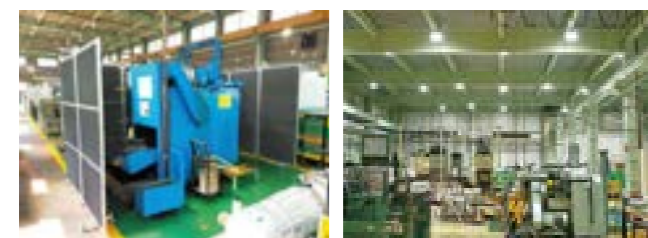
防音パネルの設置 Installation of soundproof paneling
