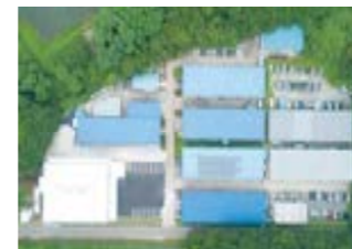
矢板工場 / Yaita Plant
