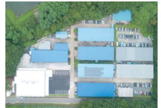
矢板工場 / Yaita Plant
